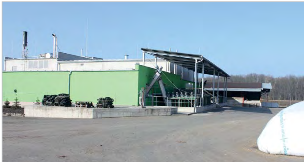
Bioplynová stanice, jejímž produktem je fermentovaný separát – stelivo do boxových loží produkční stáje
