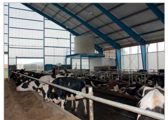
Pod střechou stáje je umístěn také vodojem
