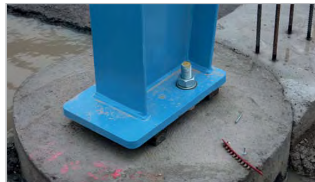
Stavba betonových pilotů
