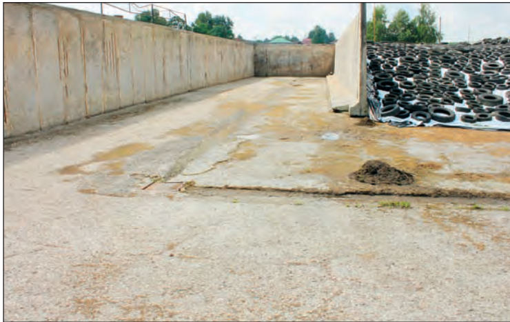
Silážní žlaby brzy čeká rekonstrukce
