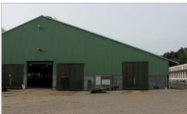
Novostavba z roku 2007 pojme 365 krav Foto Jana Velechovská
